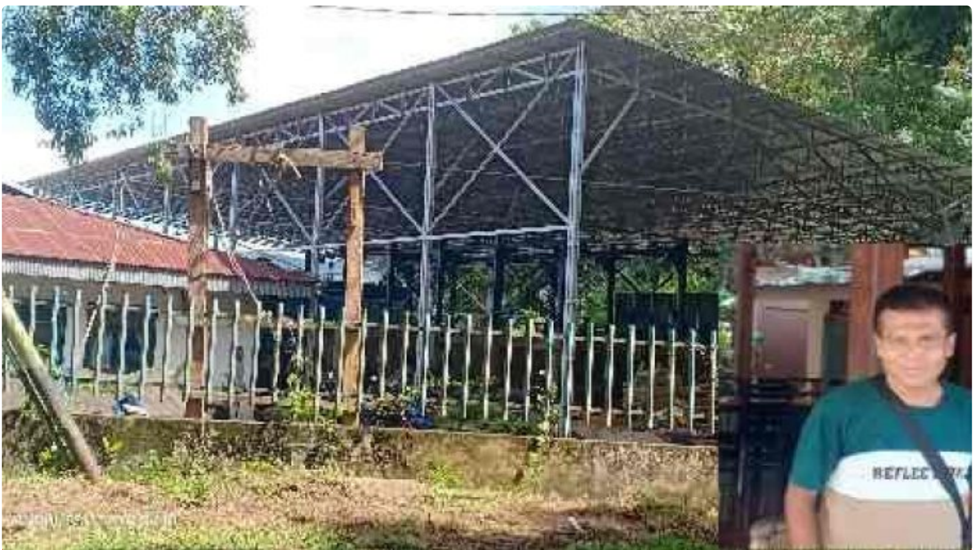
Kondisi Bangunan Pabrik Es di Kelurahan Tandurusa Tak miliki Ijin PBG
